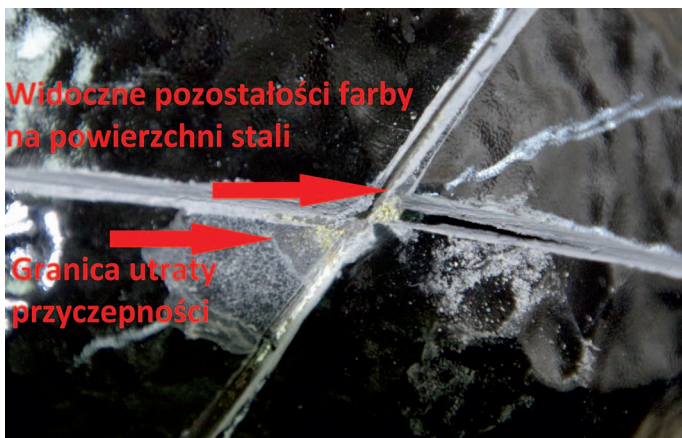
Fot. 6. Brak przylegania w miejscu nacięcia (fot. T. Minor)
