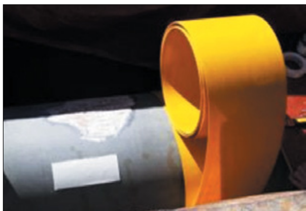
Rysunek 5. Montaż elastycznej taśmy kompozytowej ClockSpring Figure 5. Installation of the ClockSpring flexible composite tape
