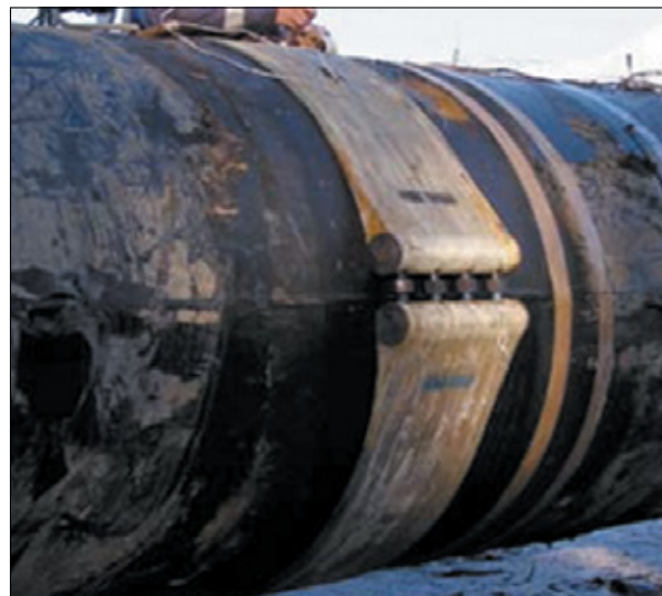
Rysunek 6. Złącze z włókna szklanego RSM Figure 6. RSM glass fiber connector
