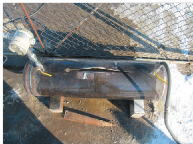
Rysunek 9. Zniszczony odcinek rurociągu o średnicy 325 mm bez rękawa z wadą sztuczną
